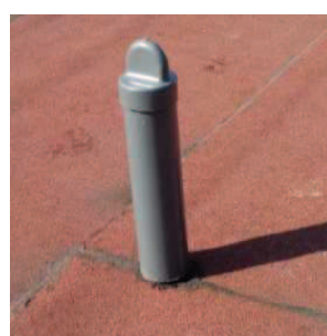
izolace kotevních bodů
