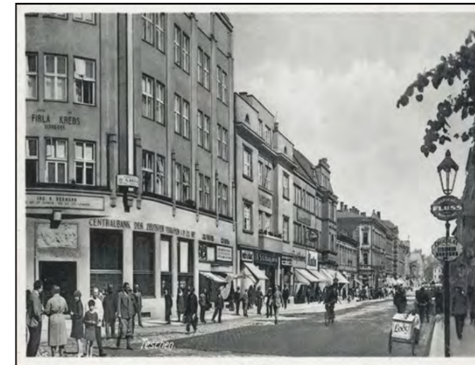
Pouliční ruch při pohledu z Nádražní ulice, rok 1940
