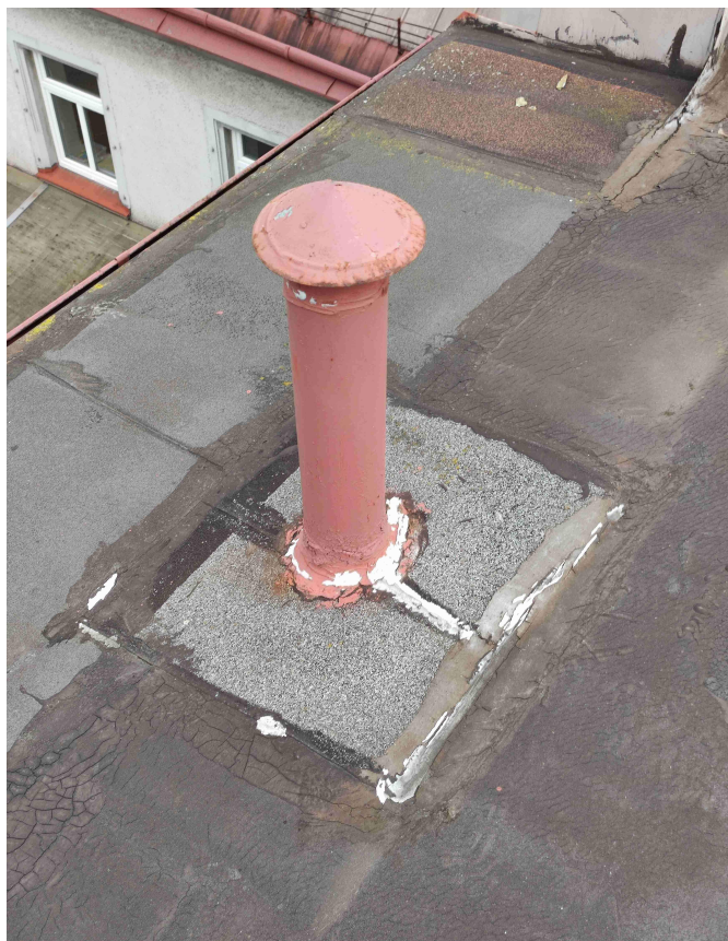
↓ Foto č. 10: Opravy zátoků kolem odvětrání kanalizace - spoj „proti vodě“, bez manžety, četné tmelení, lokální koroze komínku.
