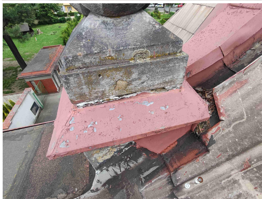
↩ Foto č. 14 : Oprýskaná barva, lokální koroze a hlavně nepružné zatmelení přechodu oplechování soklu čučky – místo aktivního zatékání
