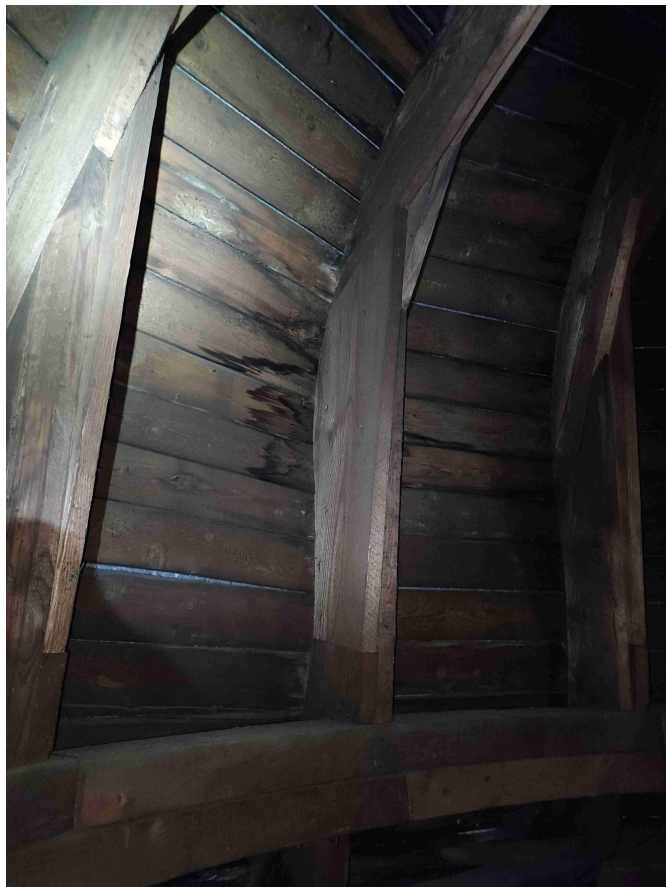
⬆ ↗ Foto č. 18, 19 : Pohled na zátoky, výluhy minerálních solí, ale i hniloby bednění věžky.
