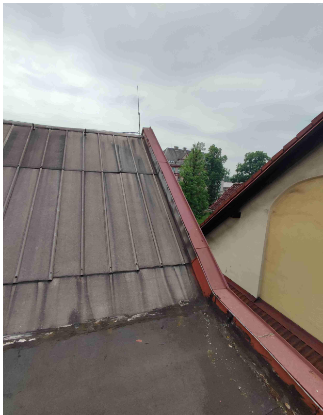
↑ Foto č. 8: Oplechování atiky, ukončení asfaltového pásu na vodorovné ploše, četné tmelení styku s lemováním atiky a napojení na plechovou krytinu.
