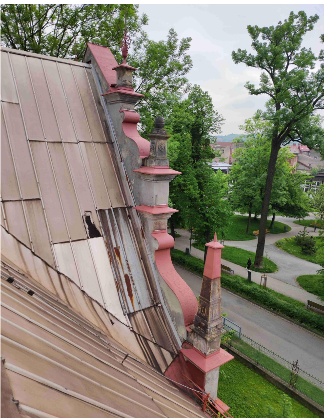
⬇ Foto č. 6: Pohled na opravovanou a rží poškozenou část střechy v místě nalezených intenzivních zátoků a hnilob
