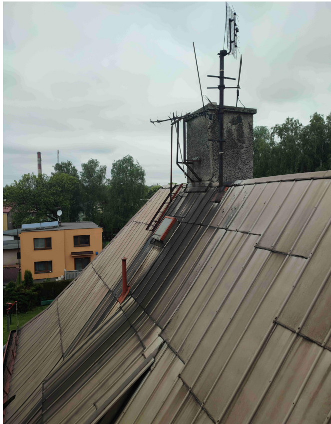
⬆ Foto č. 5: Poškození stékající rží, těžko revidovatelný a udržovatelný žebřík a komínová lávka.
