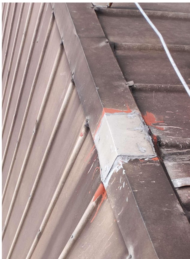
↓ Foto č. 11: Oprava (zakrytí po demontáži stožáru?) hřebene v místě prokázaného zátoku, kombinace různých materiálů.
