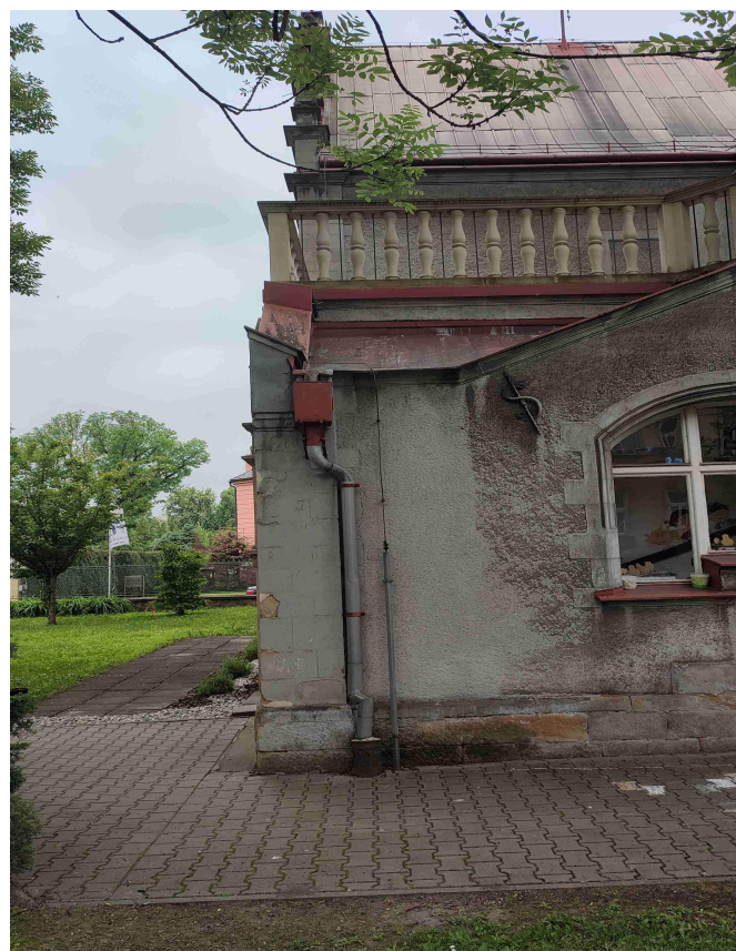
⬇ Foto č. 7: Pohled na fasádu – přetoky vody ze střechy díky často ucpanému výtoku do kotlíku.
