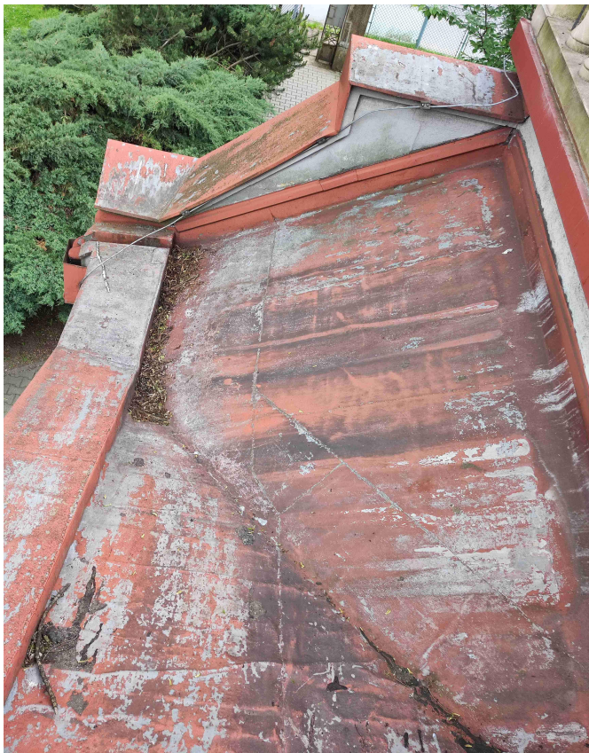
⬆ Foto č. 4: Pohled na letovanou a zvlněnou střechu nad vstupem.
