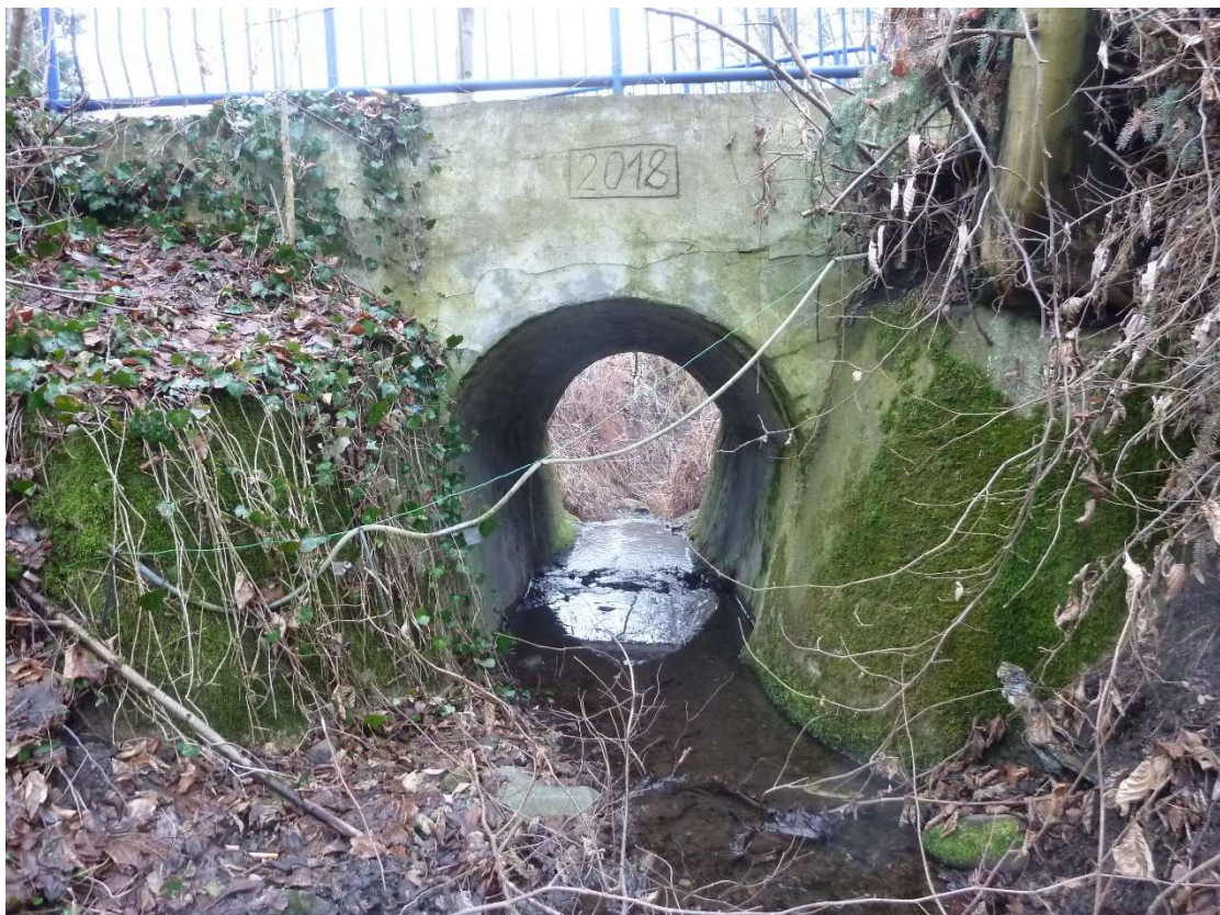
Vtokové čelo stávajícího mostu
