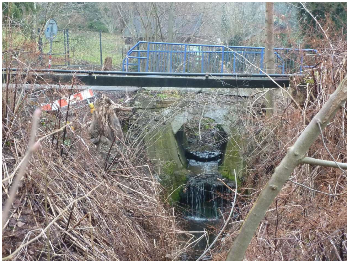
Výtokové čelo stávajícího mostu a spádový stupeň
