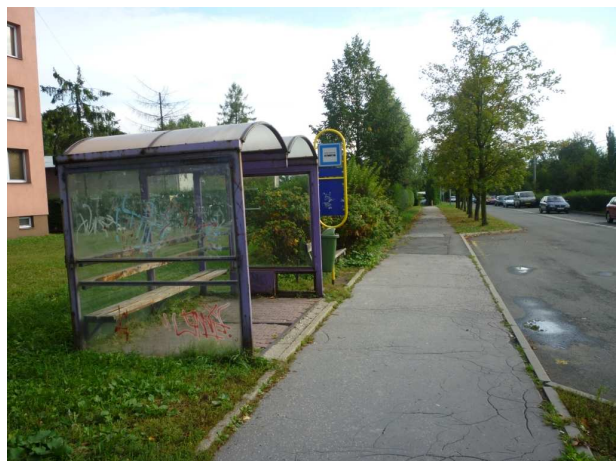
Obr. č. 1 - Stávající rušený přístřešek na autobusové zastávce
