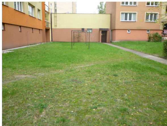
Obr. č.19 - Odstranění stávajících sušáků na prádlo
