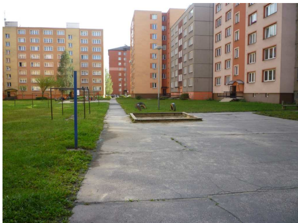
Obr. č.16 - Odstranění stávajícího sloupku na volejbal, sušáků na prádlo a pneumatik
