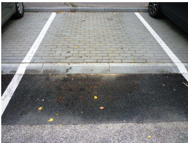
Obr. č.3 - Parkovací stání modernizované v předcházející již realizované etapě
