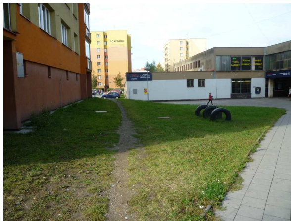
Obr. č.13 - Odstranění stávajících pneumatik
