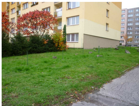
Obr. č.20 - Odstranění stávajících sloupků a drátů
